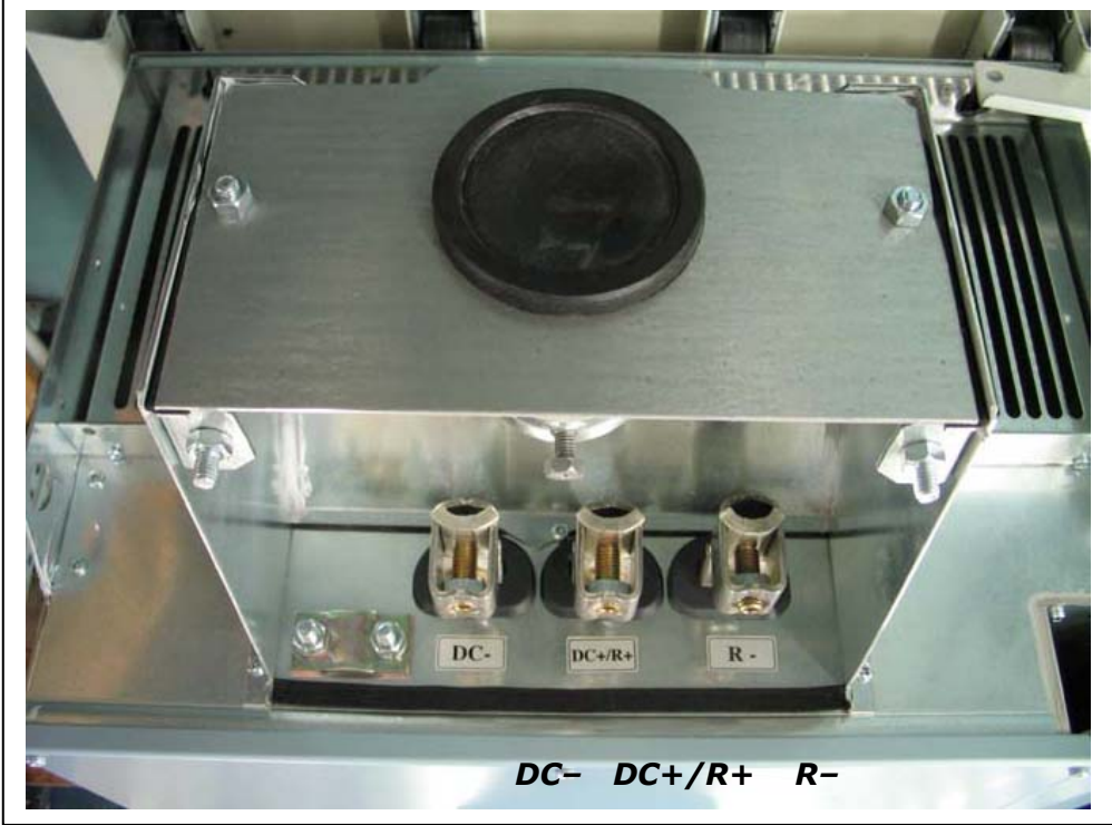
Şekil 6-18. FR9 üzerindeki DC ve fren rezistör terminalleri; DC- ve DC+ ile işaretli, DC terminalleri R+ ve R- ile işaretli rezistör terminalleri
